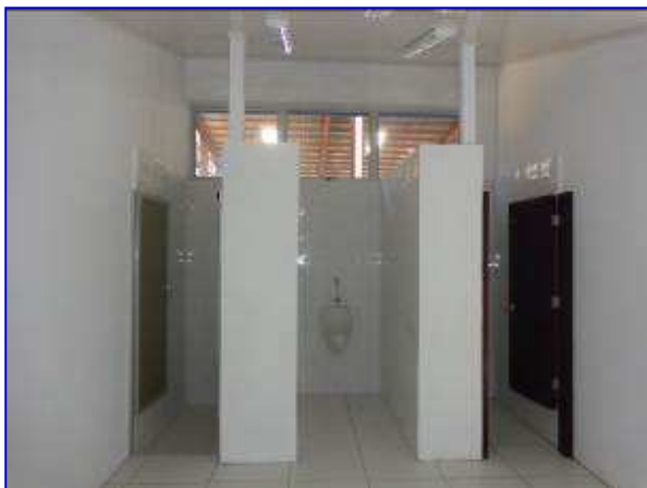
Vista interna del área de servicios sanitarios árbitros - Gradería Este, donde se aprecia la ejecución de las actividades de pisos, lámparas, puertas de aluminio y lámina acrílica rugosa, instalación de aparatos sanitarios.
